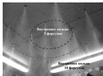
Рис. 2. Фото форсунок, расположенных в потолке холодильной камеры для создания ледяного облака
