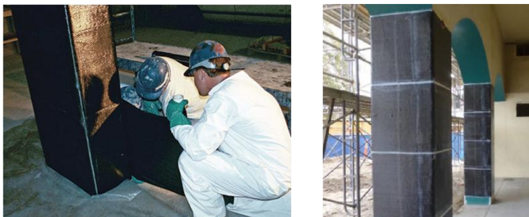
Рис. 1. Армирование бетонных конструкций углеродной лентой
